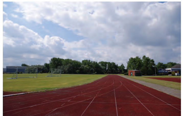
Abb. 32 Sanierungsbedürftige Sportanlage aus Bundeswehrzeiten
