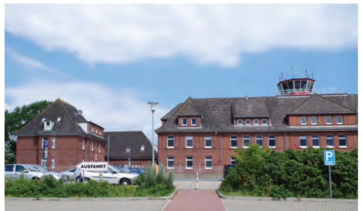
Abb. 13 Bundeswehr-Gebäudekomplex am Fährhafen
