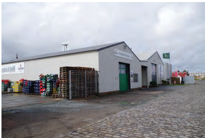
Abb. 14 Gewerbebetriebe am Südpier mit Bedarf an Wasserzugang
