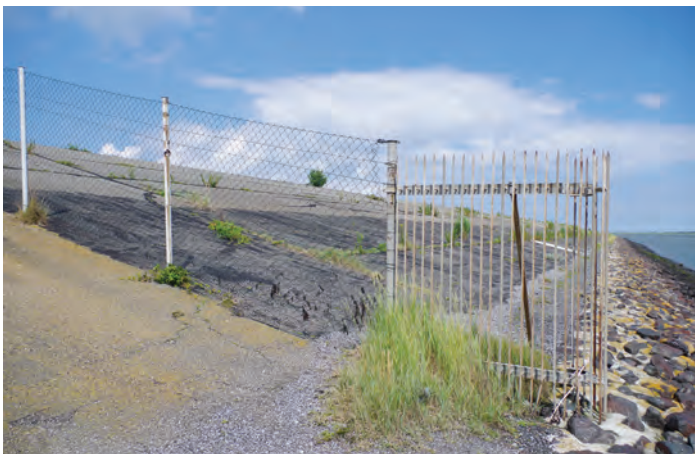
Abb. 33 Zaun am Zugang zum nördlichen Teerdeich
