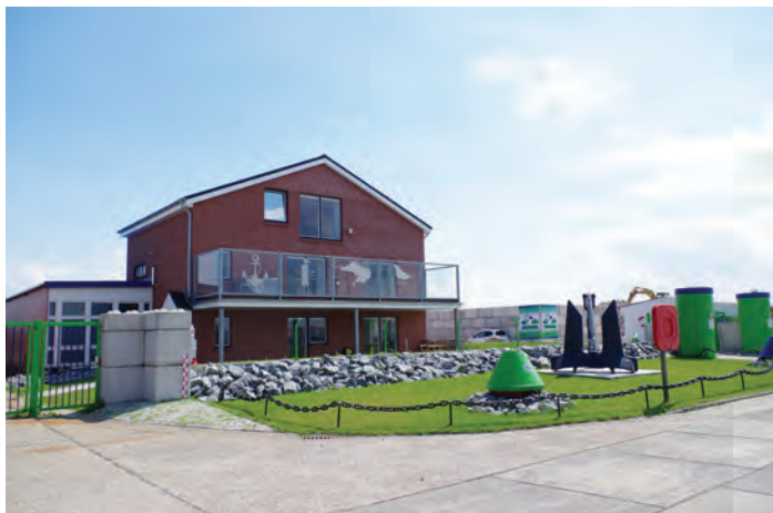
Abb. 15 Gewerbebetrieb an der Ostkaje
