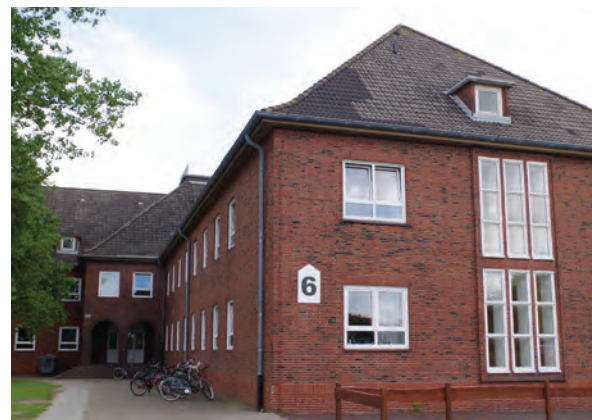
Abb. 21 (barrierefreier und energetischer) Sanierungsbedarf der Jugendherberge
