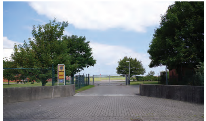
Abb. 34 Hochwasserschutzmauer mit Deichscharte an der Reedestraße
