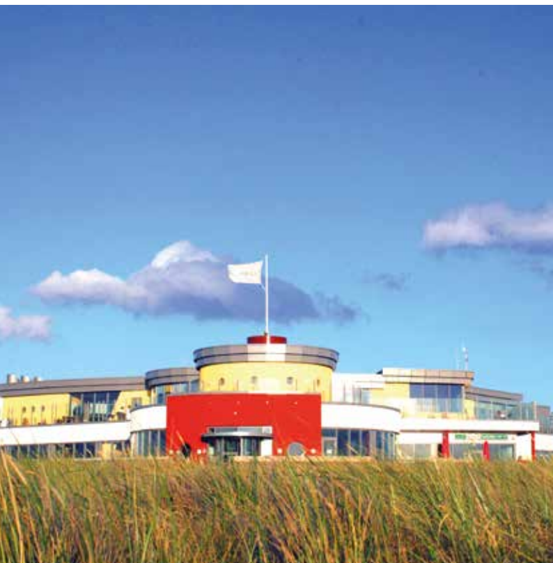
Auch das Gezeitenland ist nun über zehn Jahre alt – und bedarf einer grundlegenden Sanierung.
