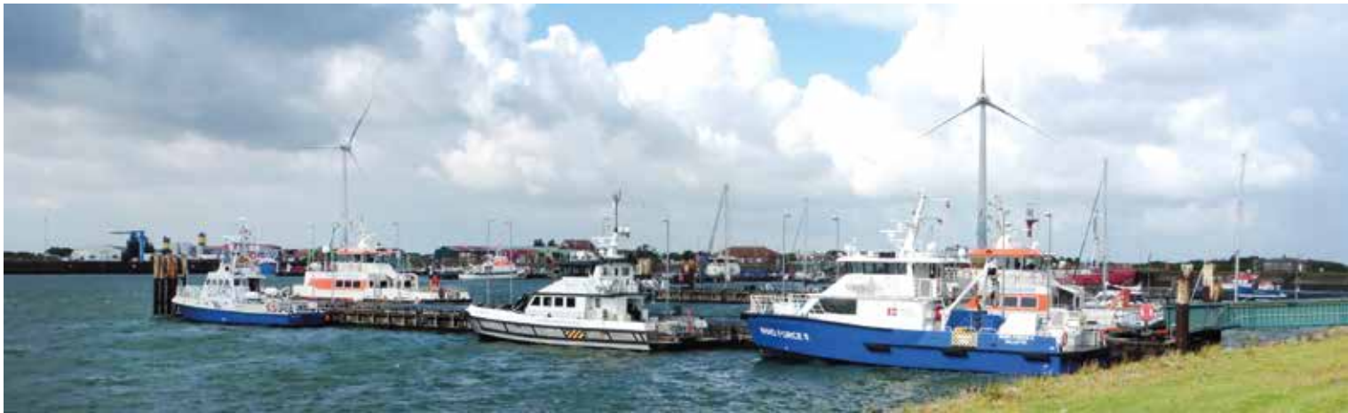
An der Ostkaje können große Transportschiffe anlegen und entladen.
