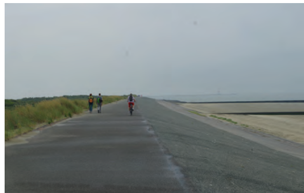
Abb. 59 Betondeich am Südstrand
