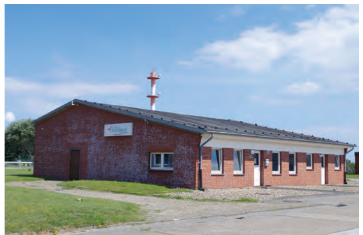
Abb. 29 Nordsee windport Borkum im Ortsteil Reede
