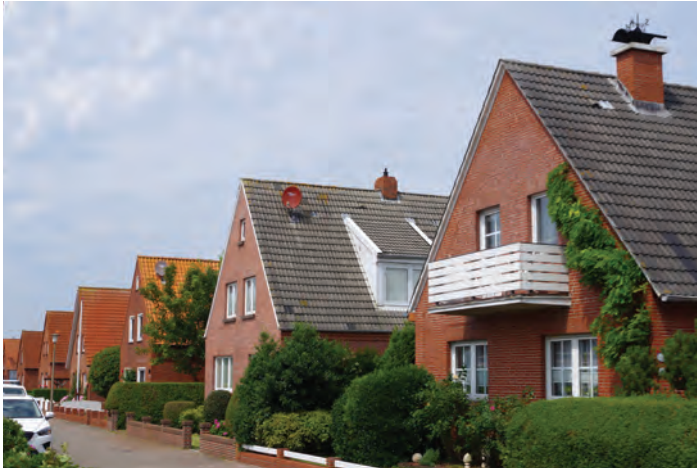
Abb. 52 Ortstypische Giebelständige Bebauung mit rotem Klinker
