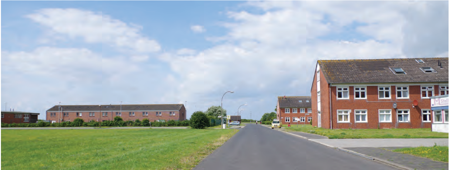
Abb. 64 Nachgenutzte Kasernengebäude entlang der Juister Strate mit großen Brachflächen
